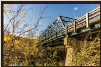
Le pont Shaw en 2016 [d] © Gaston Bessette
