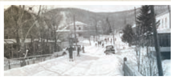
Le Riverside du côté sud du pont Shaw [c]
