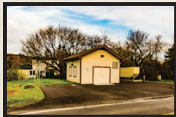
Ancienne place du Marché public [d] © Gaston Bessette
